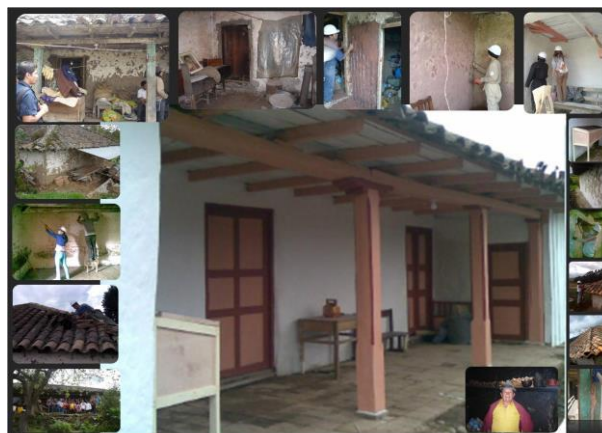
Figura 61. Intervención de edificaciones en tierra.
