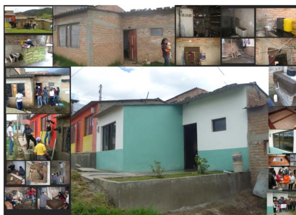
Figura 62. Intervención de acabados.
